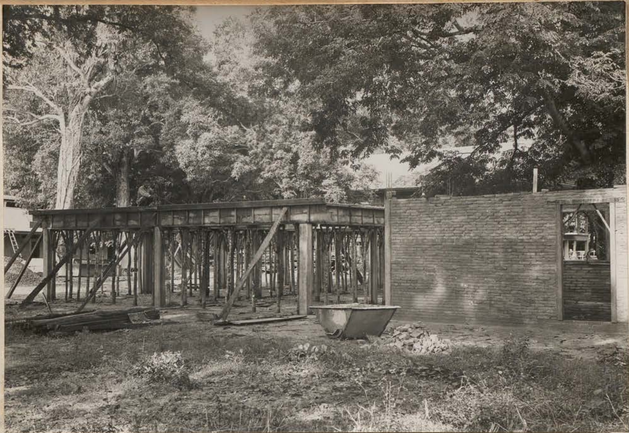
8505- EFEO- Villa n° 3. Travaux en cours
