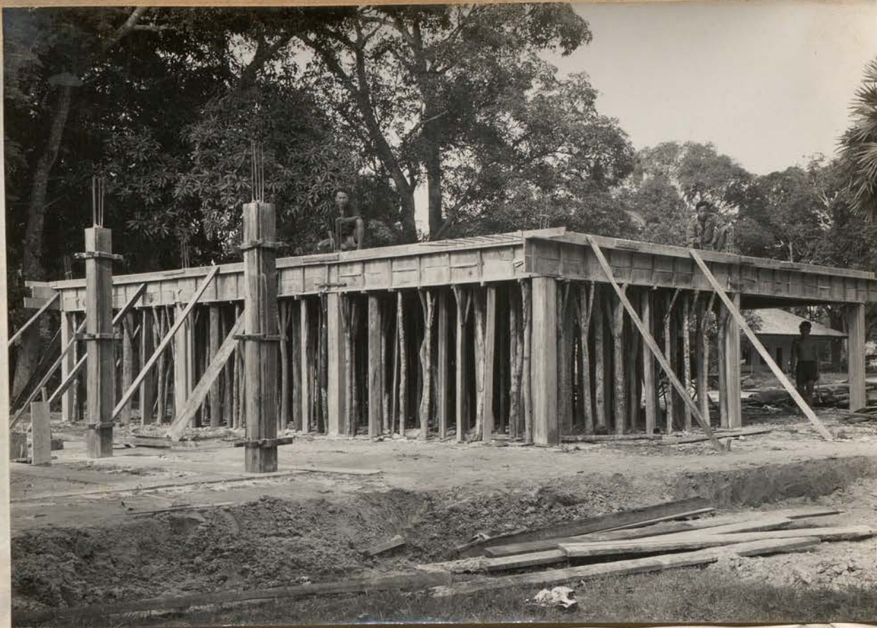
8503. EFEO. Villa n°2. Couloir de la dalle. 7 Sept 59
