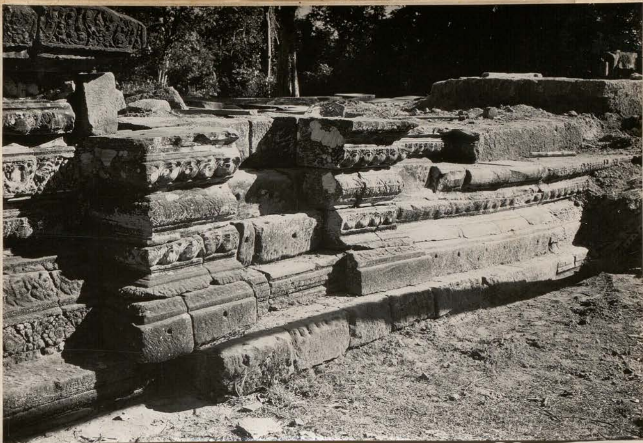
8500 . Thommanom. Gopura E Porte W et Namdapa pati E. Soubassement extérieur 2 e état - Fau Sud - 21 nov. 1959
