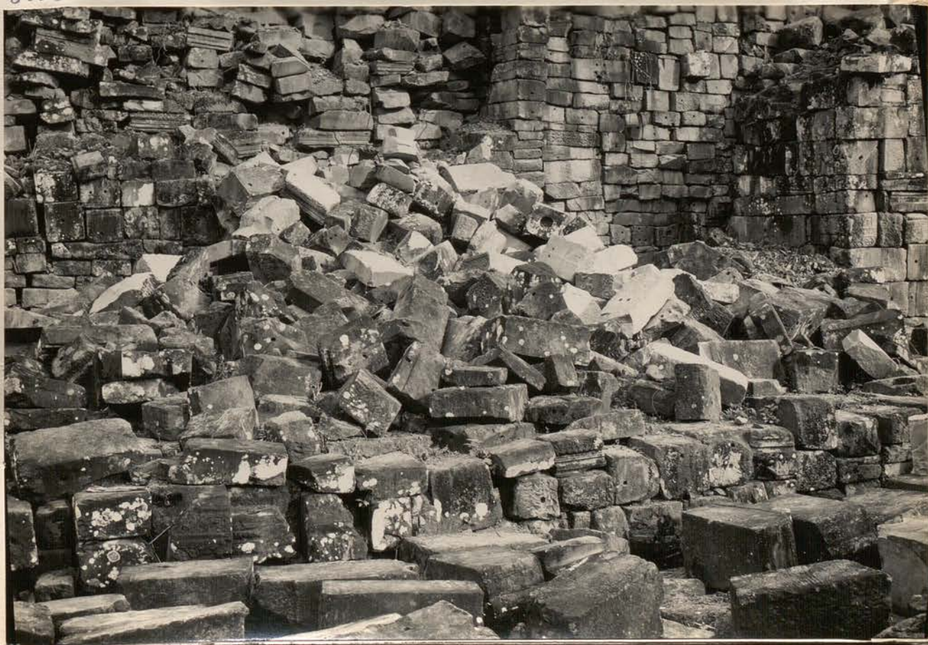
8508- Baphuon- Face Ouest- I er étage- 21. dec. 59 éboulement sous la Vêtu du Buddha couché
