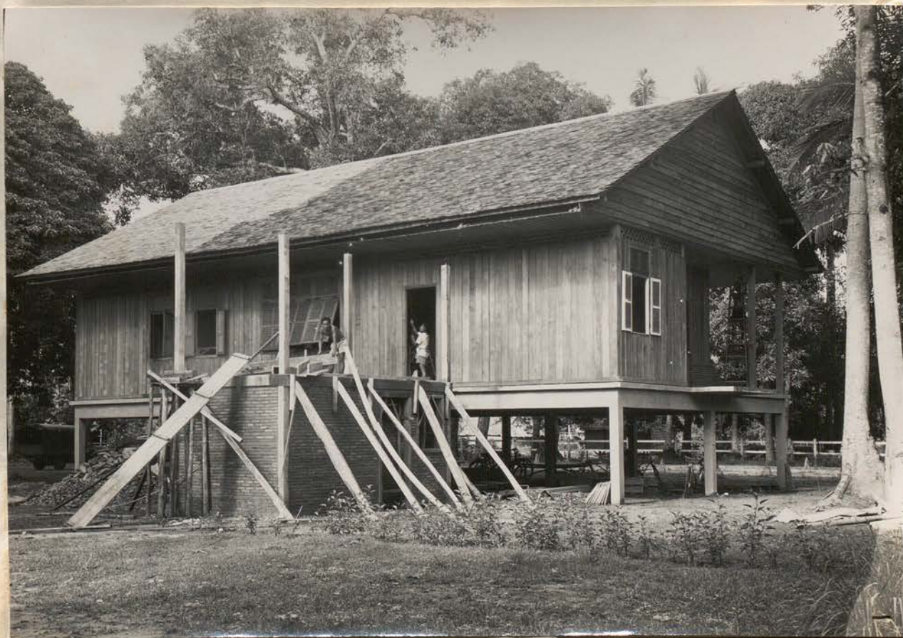
9504. EFEO. Villa n°1 - dépendances en cours de construction. 5 oct. 59
