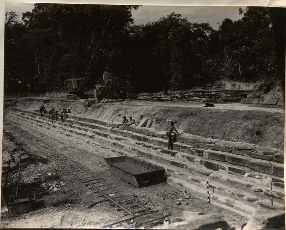
8364. Fin mai 58. Barrin central - Côté Ouest - Pose du 6 e gradin -
