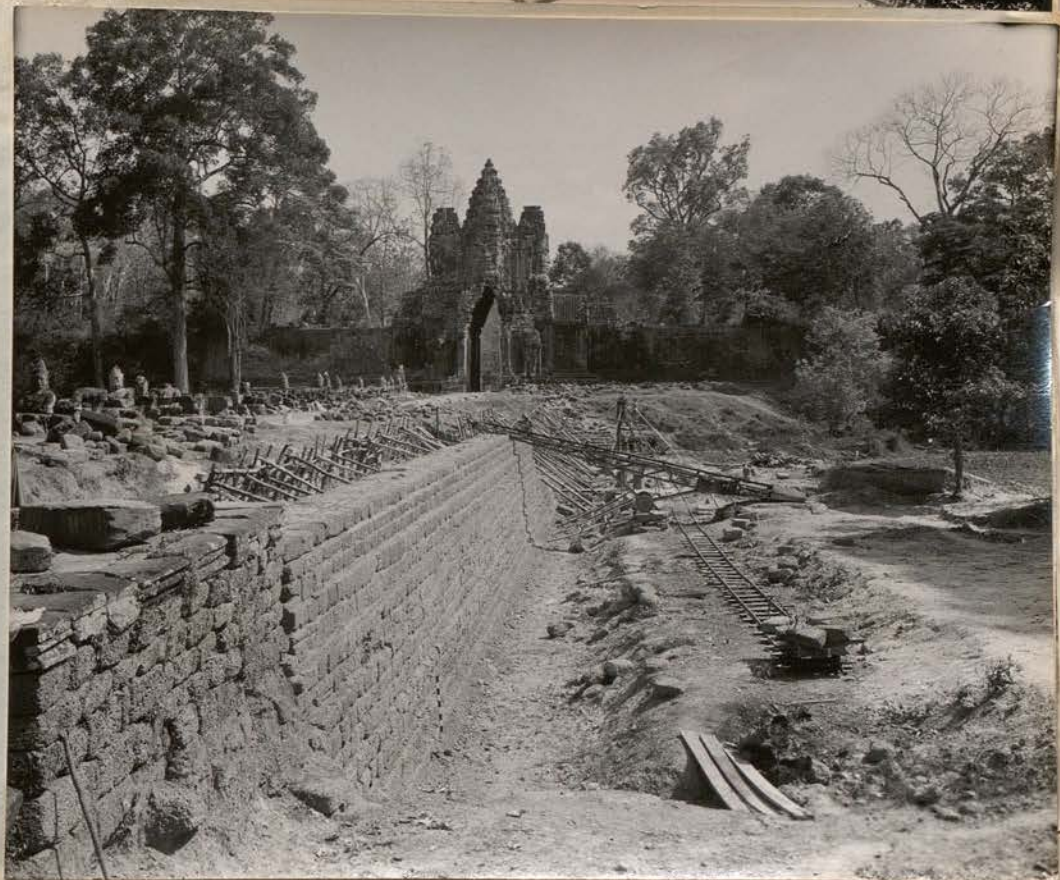
8355- 30 avril 58. Porte S. d'Angkor Thom. Vue Est vers N-
