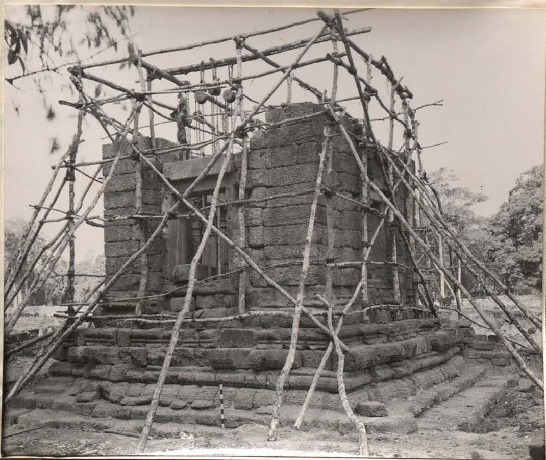
8360- fin avril 58- 1d- Face Ouest est après mise en place du linteau en béton.
