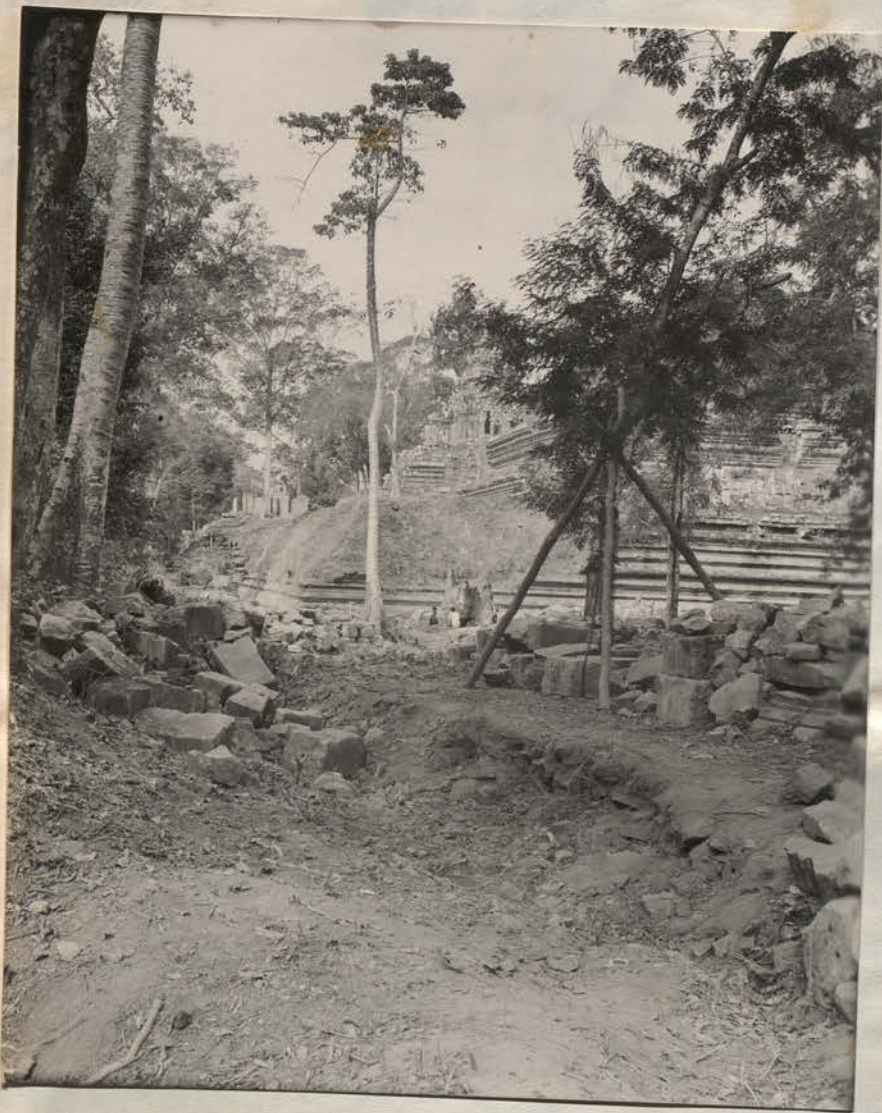
8287. Janv. 57. Baphuon - aménagement d'accès à l'angle S.E. - Vue vers N.W.
