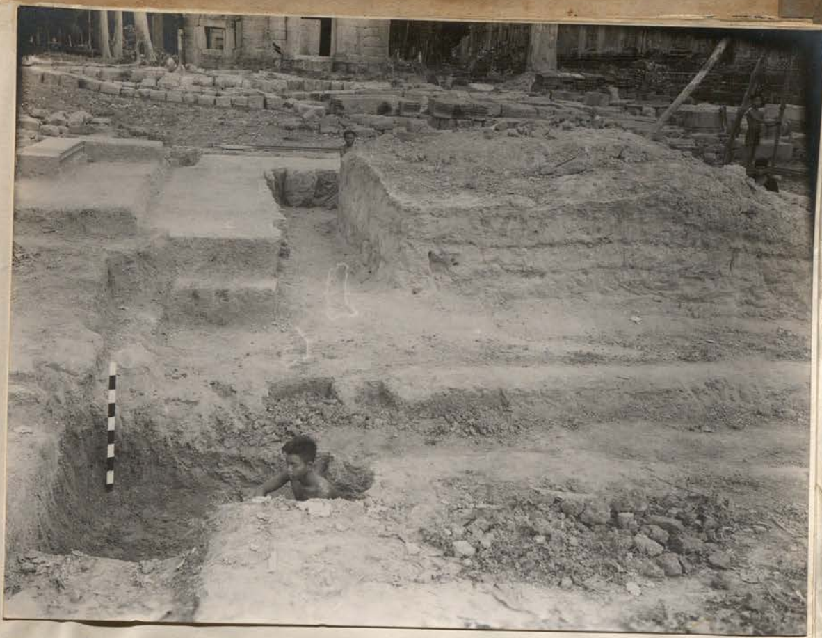
8290. Janv. 57. Pr. Suor Prat n° 4. Côté S. du soubassement - tranchée creusée pour la fondation nouvelle -
