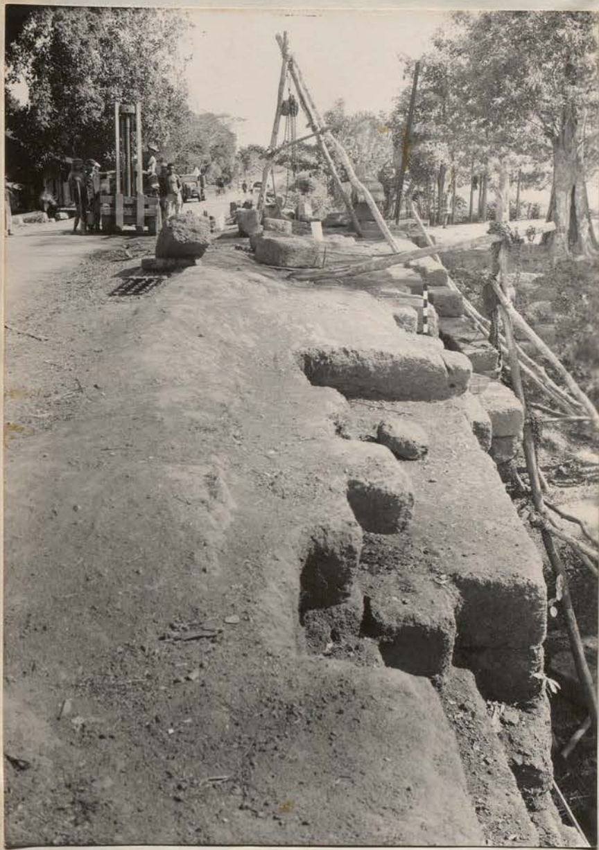
8295. 70 Janv 57. Pont de Kompong Kdei - Repose du riv. Sud.
