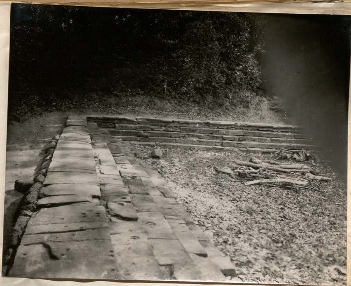
8339. Dec 57. Neak Peam. Petit barrage Nord. Aménagement du chemin routier -
