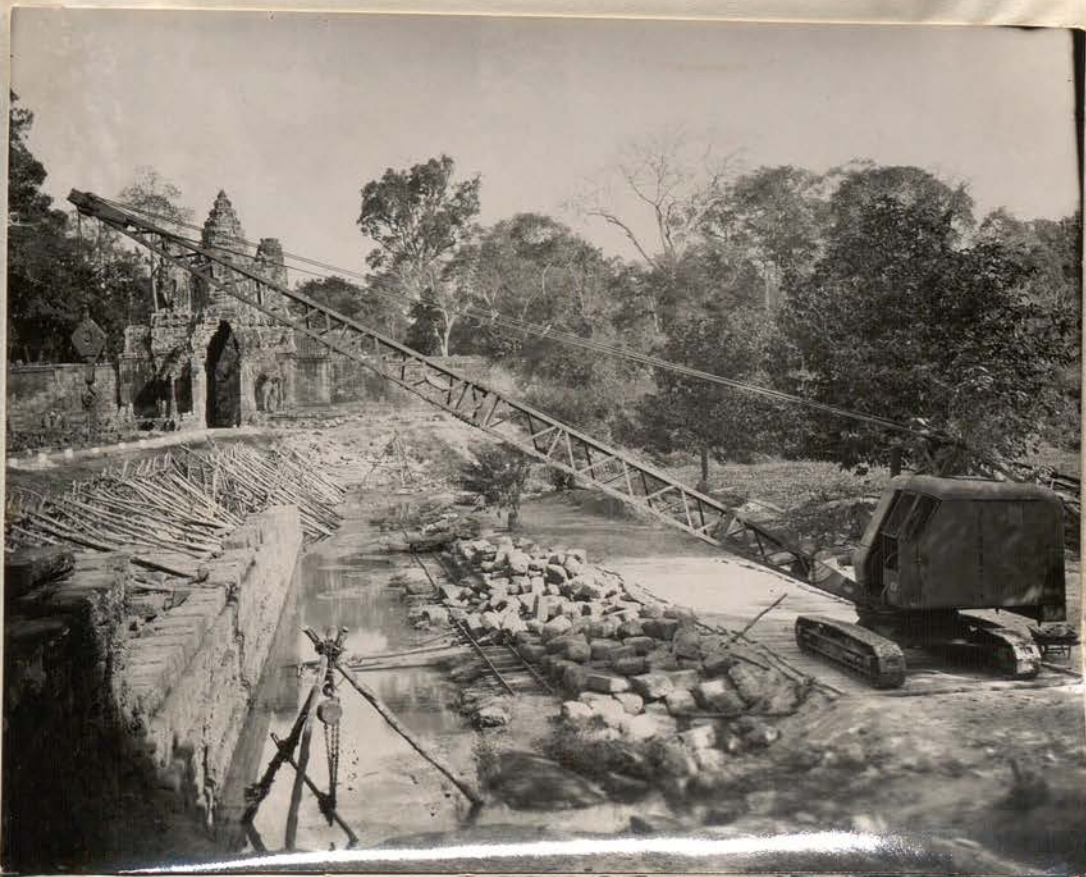
8336. Id vue vers le N. installation de la grue.
