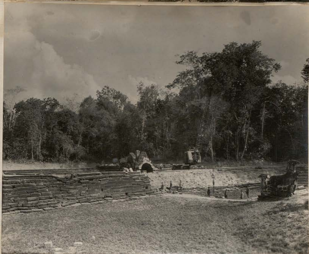
8403- Janv 59. Neak Pean. Barrin central - Côte Est - dépose des gradins
