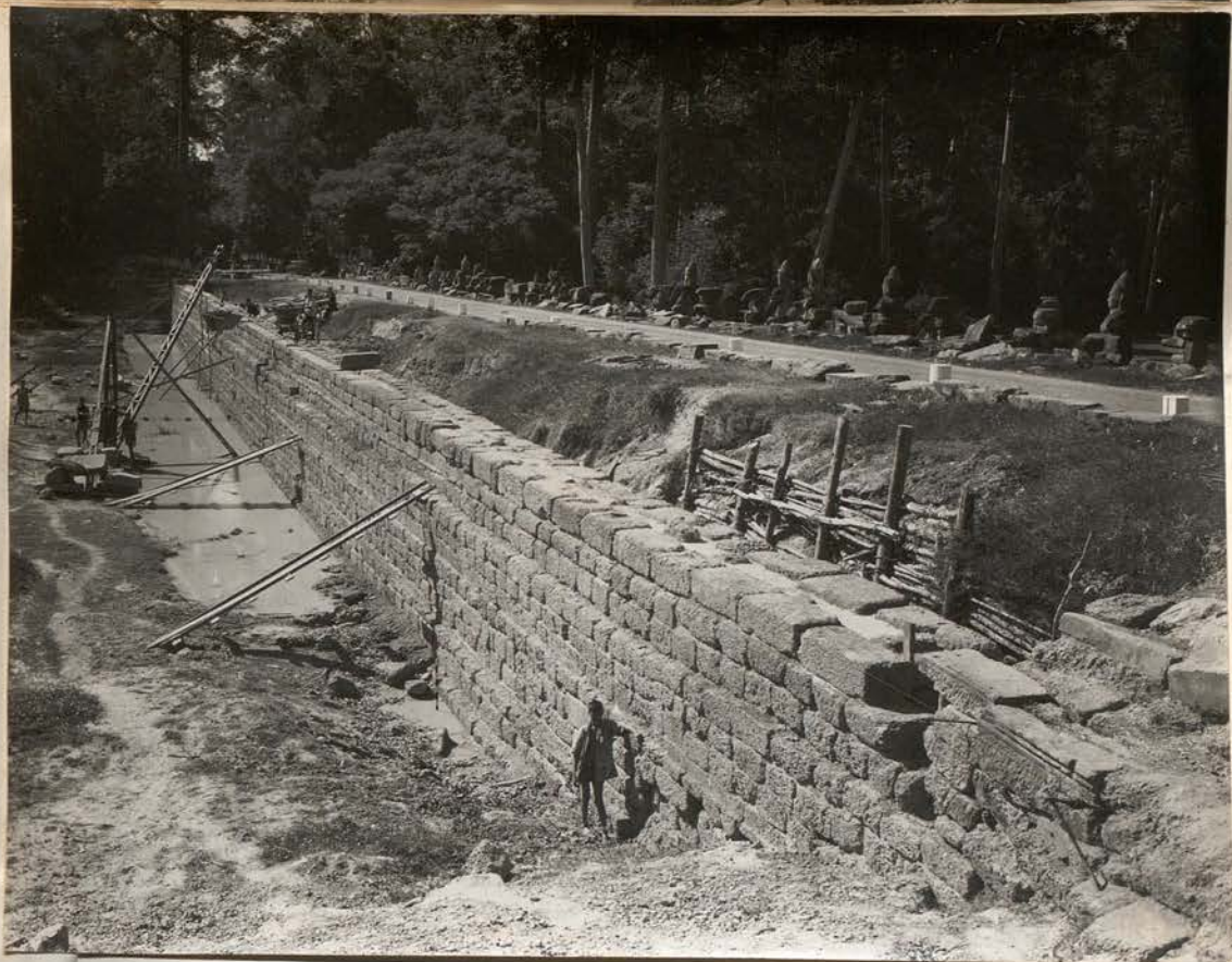
8396. dec 58. Angkor Thom. Porte S. Mur Est - Repose de la derniers années de l'akéite et début du bourrage des terres - Vue vers le S. W.
