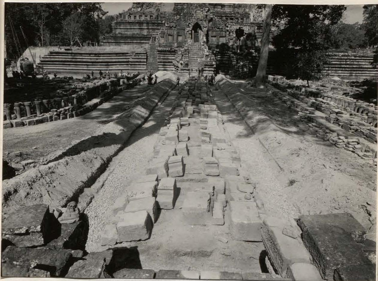
A.- Baphuon - Chaussée Est, section Ouest. Confection de la semelle de fondation des bahuts - 20 mars 1961 (Ph. 13 x 18 n° 9014).
