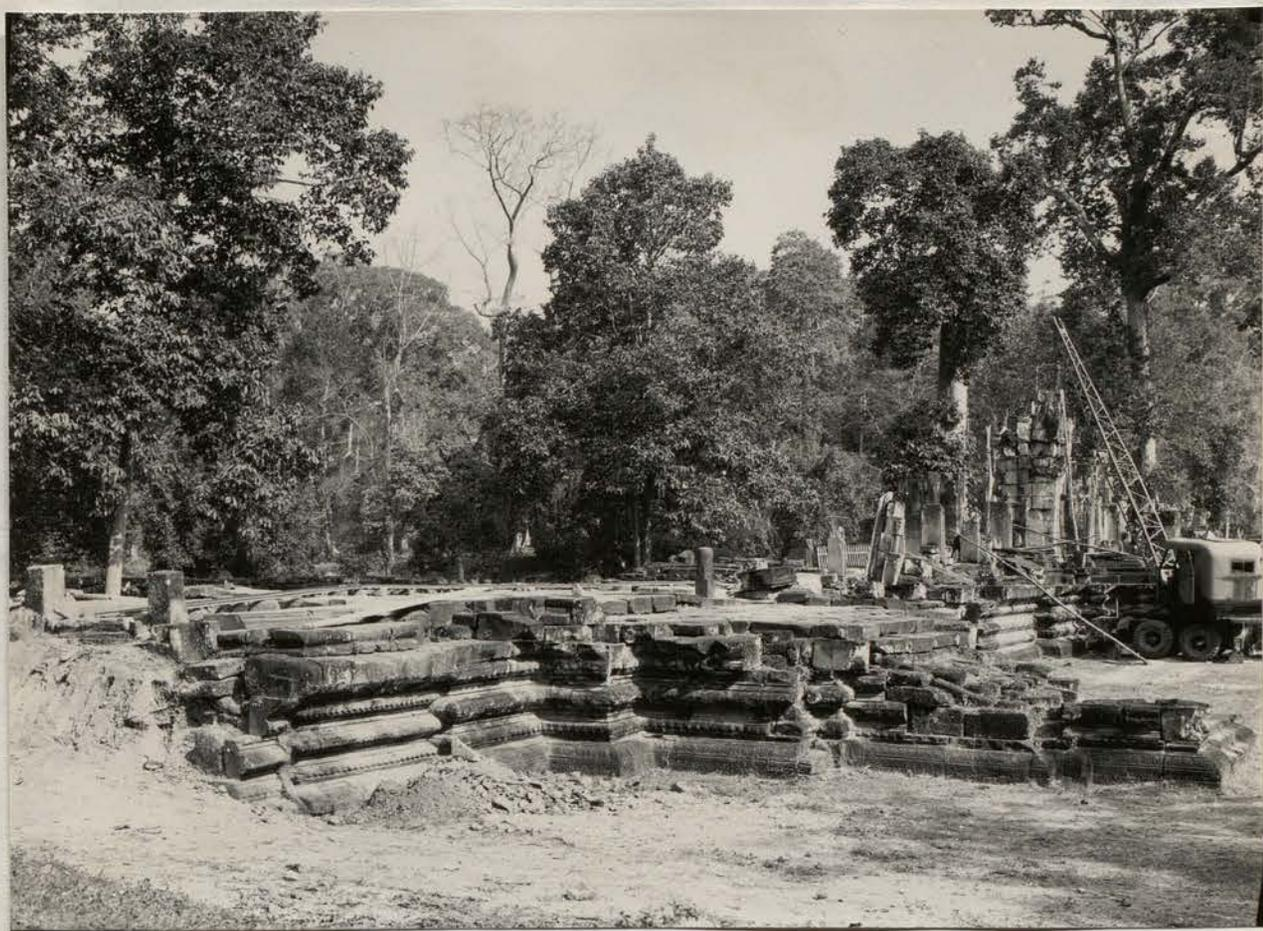
A.- Baphuon - Gopura 5 Est, pavillon central en cours de dépose - 22 mars 1961 - (Ph. 13x18 n° 9019).
